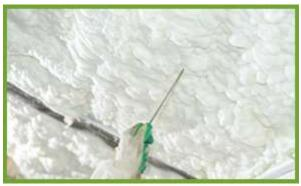
Технология напыляемого пенополиуретана позволяет проводить работы по монтажу теплоизоляции в рекордно короткие сроки – так, ангар площадью более 2000 кв метров можно полноценно утеплить всего за 3 дня.
